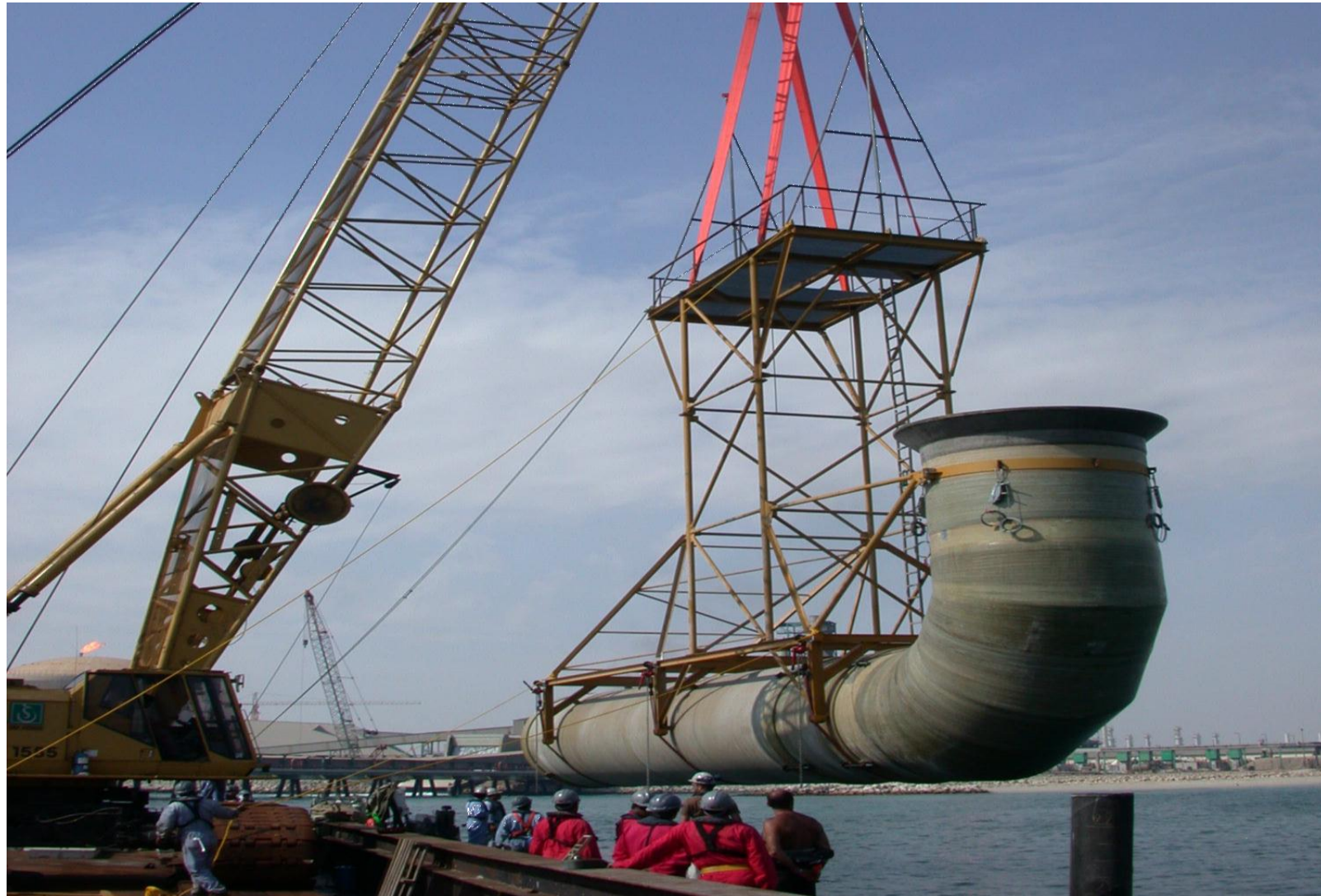
Instalare teava de aspiratie GRP FIBERSTRONG®
