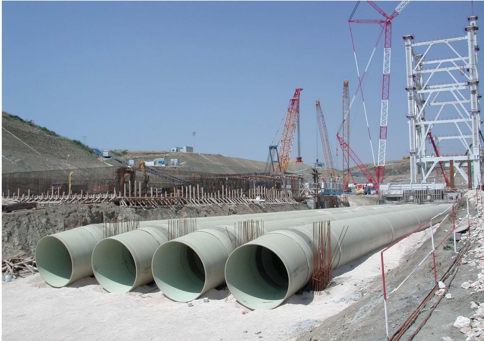
Tevi Fiberstrong® DN 3500 – sistem de racire cu apa la centrala electrica din Iskenderun (Turkey)
