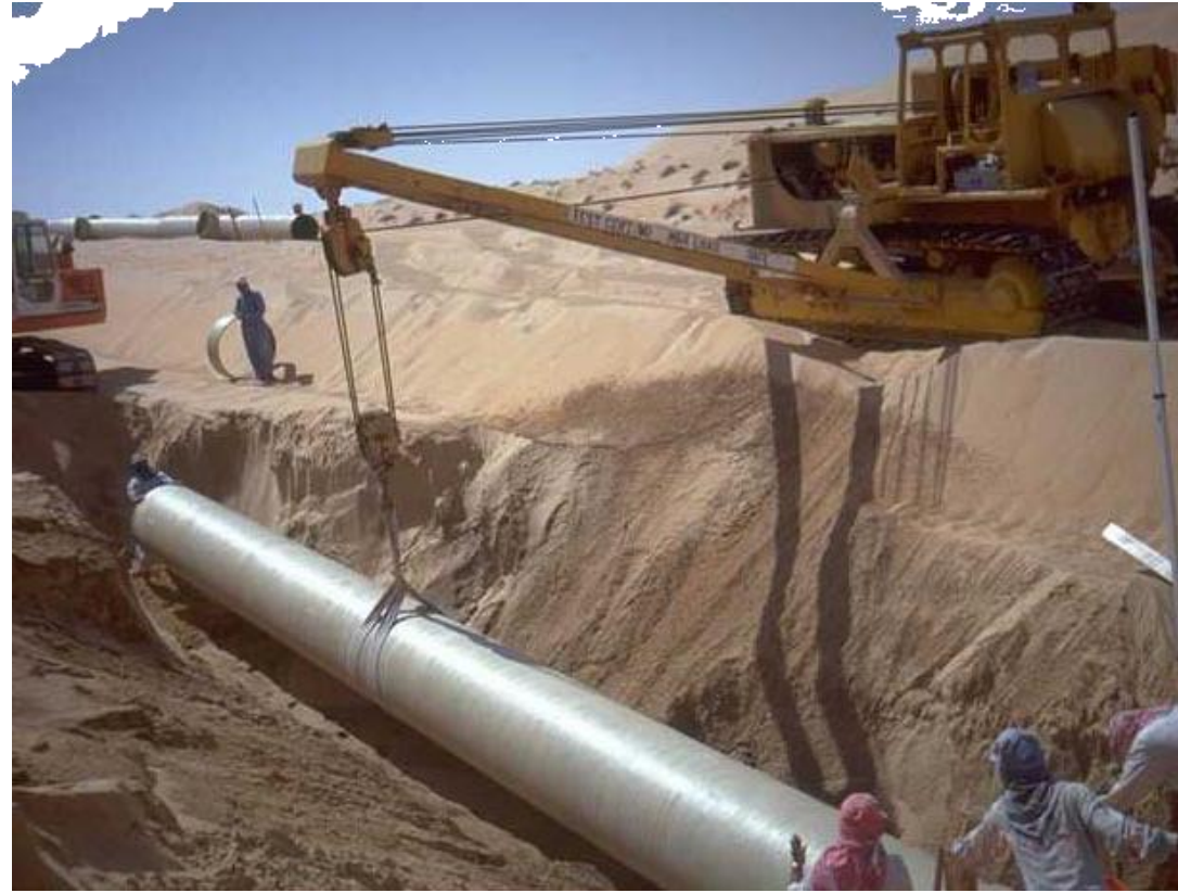
Instalare in sant foarte instabil - nisip
