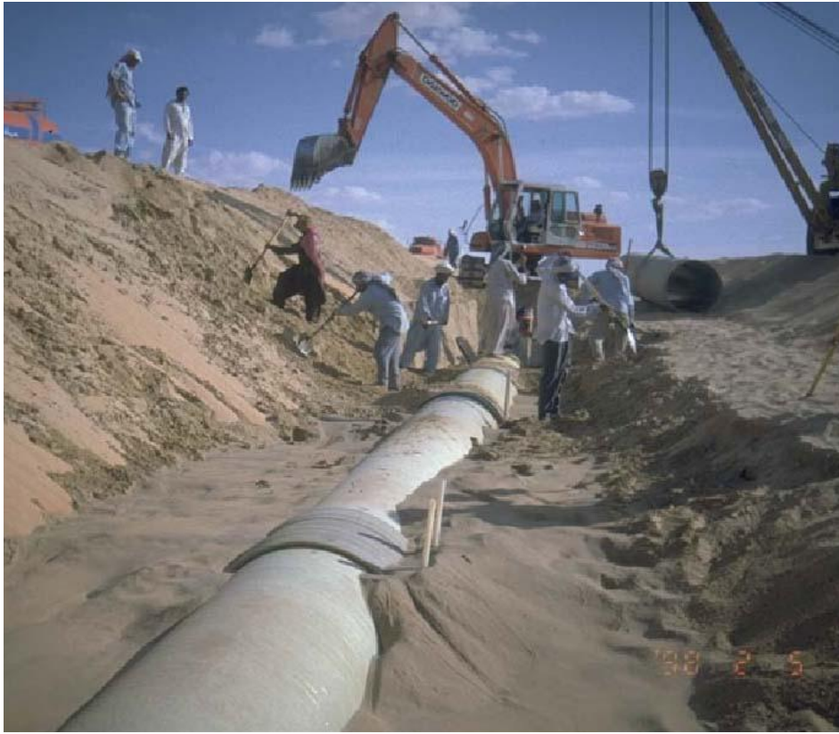
Sistem de tevi Fiberstrong® (tip PAFSIN) DN 900, PN16, lungime totala 70 km
